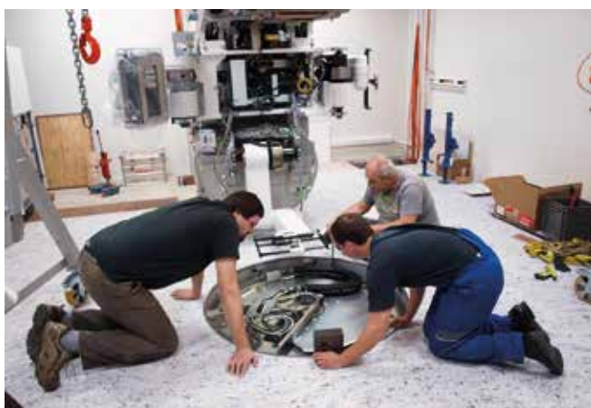
Lineární urychlovač II začali odborníci instalovat v říjnu.
