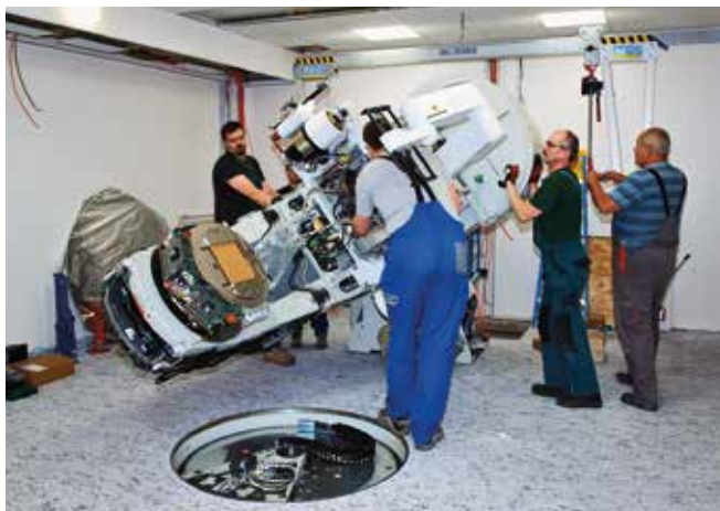
Usadit mohutné zařízení pomohl montérům kladkostroj.
